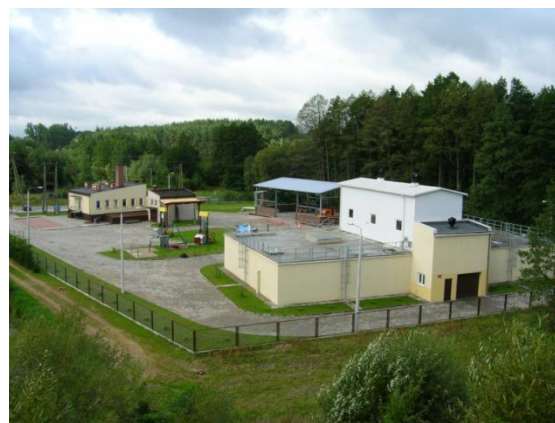
Rysunek 1. Oczyszczalnia ścieków w Dąbrowie Białostockiej
