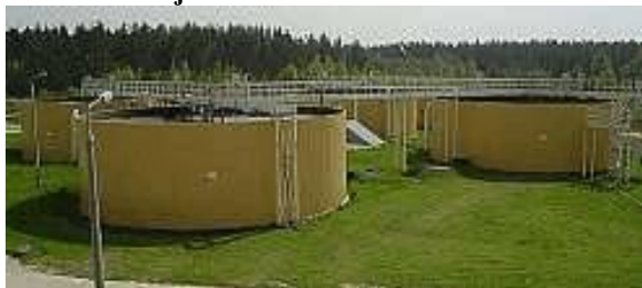
Rysunek 2. Reaktory biologiczne oczyszczalni ścieków w Hajnowce
