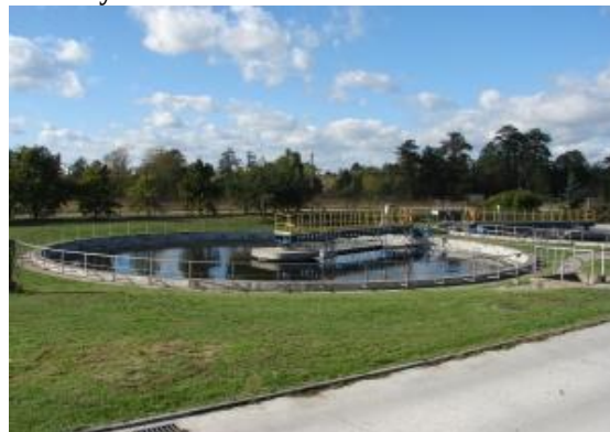
Rysunek 3. Oczyszczalnia ścieków w Siemiatyczach
