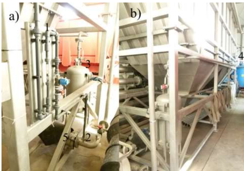
Rysunek 3. Urządzenia współpracujące z flotatorem, służące do nasycania ścieków powietrzem: a) widok na zestaw saturacyjny, b) widok ogólny na flotator; 1 – przewód ssawny powietrza, 2 – zawór iniekccyjny, 3 – zbiornik saturacyjny, 4 – wlot mieszaniny ścieków i powietrza na flotator, 5 – pompa saturacyjna
