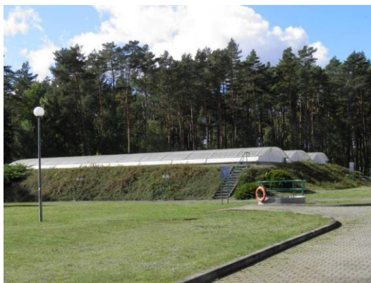
Rysunek 7. Zbiorniki wody czystej na terenie kompleksu stacji uzdatniania wód w Mostowie
