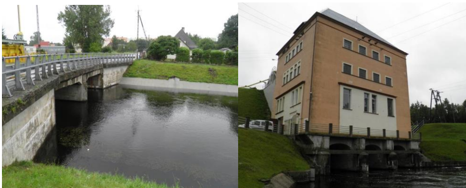
Rysunek 8-9. Kanał Rosnowski ze służą wlotową (po lewej), budynek elektrowni od strony wylotowej oraz kanał odpływowy do zbiornika Hajka (po prawej)
