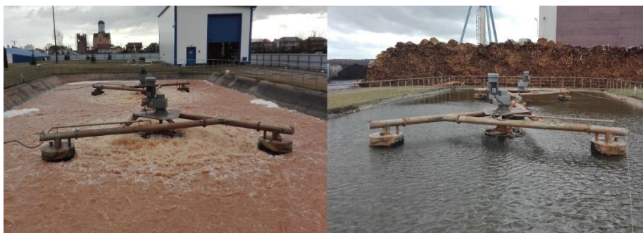
Rysunek 1. Reaktory SBR pracujące w oczyszczalni ścieków S.M. Bielmlek w Bielsku Podlaskim: po lewej – reaktor w fazie napełniania i reakcji, po prawej – reaktor w fazie sedymentacji
