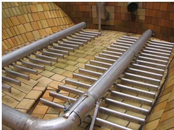
Rysunek 4. Instalacja napowietrzania w reaktorze MBBR
