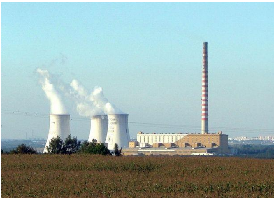
Rysunek 1. Elektrownia Jaworzno: z lewej trzy chłodnie kominowe, z prawej komin
