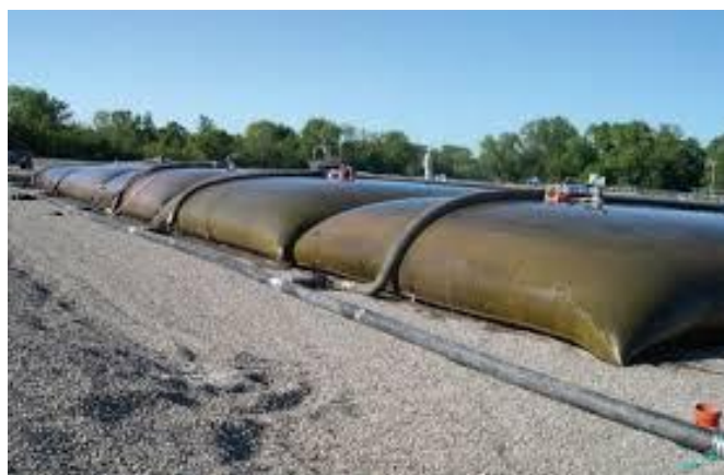
Rysunek 6. Napełnianie geotub - widoczne kominki
