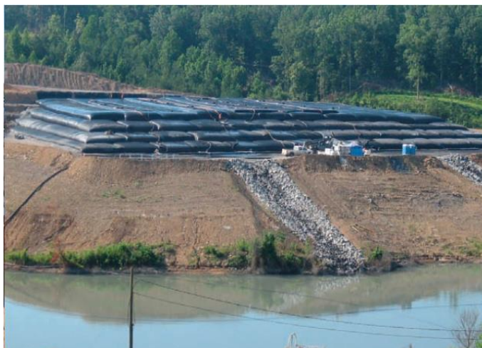
Rysunek 2. Proces napelniania geotub
