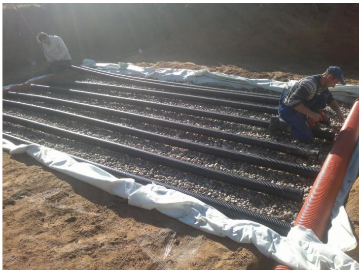
Rysunek 5. Montaż gruntowego powietrznego wymiennika ciepła typu grzebieniowego
