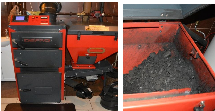
Rysunek 10. Kocioł na ekogroszek z podajnikiem szufladowym i sterowaniem automatycznym w Bielsku Podlaskim (ul. Chmielna)
