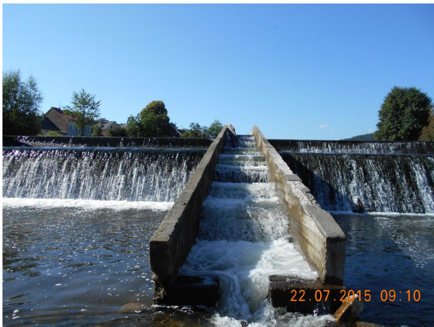
Rys. 1. Wylot z przepławki przy stopniu wodnym Głuchołazy na rzece Biała Głuchołaska
