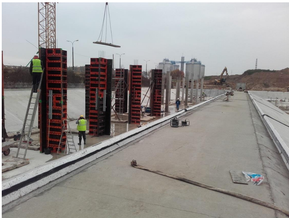
Rys. 2. Reaktor biologiczny w fazie budowy
