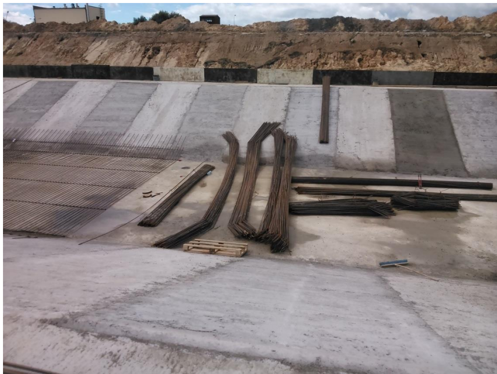
Rys. 3. Przygotowanie zbrojenia niecki reaktora biologicznego
