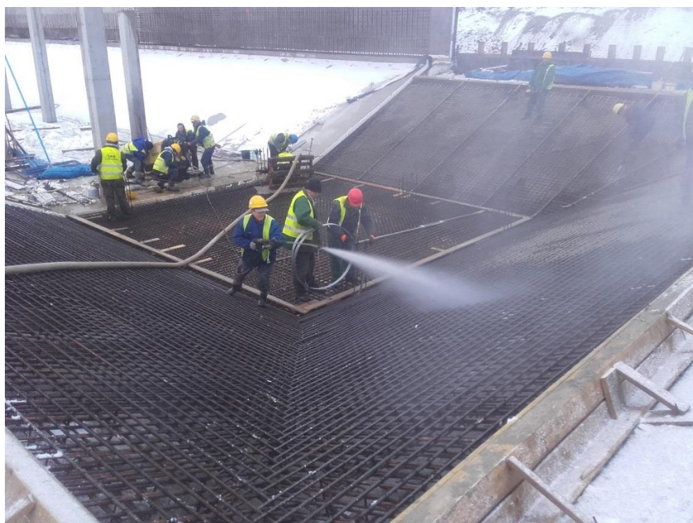
Rys. 5. Czyszczenie z lodu podłoża i zbrojenia przed betonowaniem
