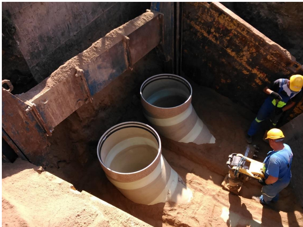
Rys. 4. Budowa komory z rurociągami GRP doprowadzającymi ścieki
