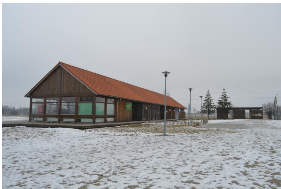
Rys. 4. Widoczny w dali budynek z miejscem do selekcji odpadów, przy wejściu na teren ekomariny
