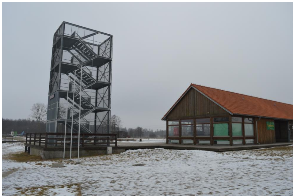
Rys. 3. Wieża obserwacyjna od strony nabrzeża
