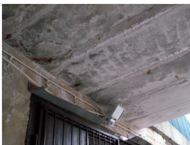
Rys. 1. Wilgoć kapilarna - widoczne wytrącone sole
