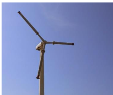
Rys. 2. Trójłopatowa turbina wiatrowa o osi poziomej z rotorem Magnusa
