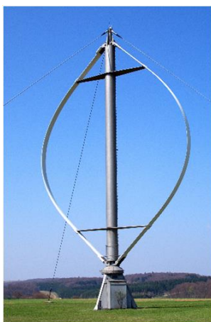
Rys. 5. Turbina Darrieusa z parabolicznymi łopatom
