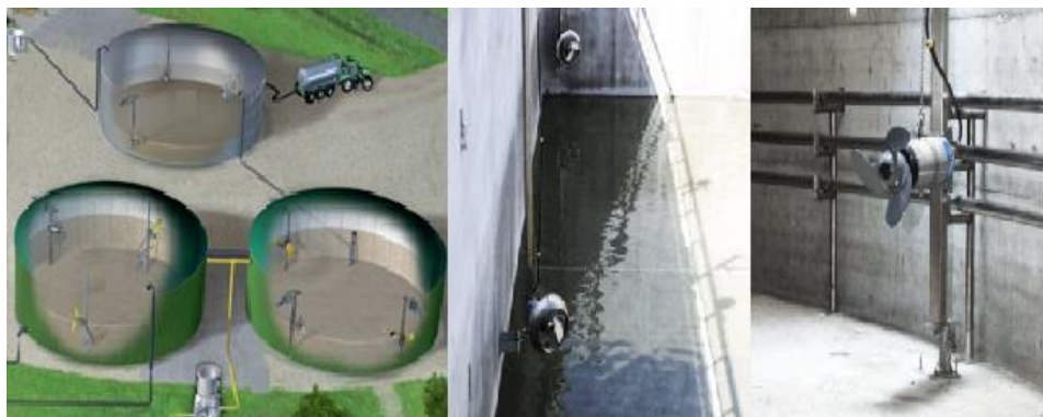
Rys. 8. Umieszczenie mieszadeł zatapialnych w zbiorniku fermentacyjnym
