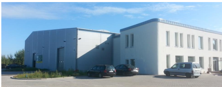
Fot. 3. Pasywny budynek biurowy firmy PCBP z zapleczem produkcyjnym, po zakończeniu robót Źródło: Fotografie autora
