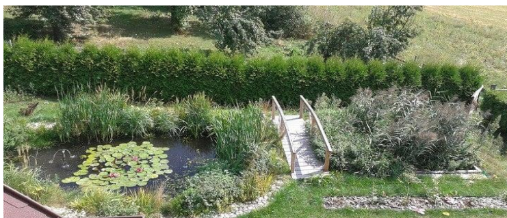
Rys. 5. Trzcinowa oczyszczalnia ścieków wraz z ich odbiornikiem w postaci stawu natleniającego
