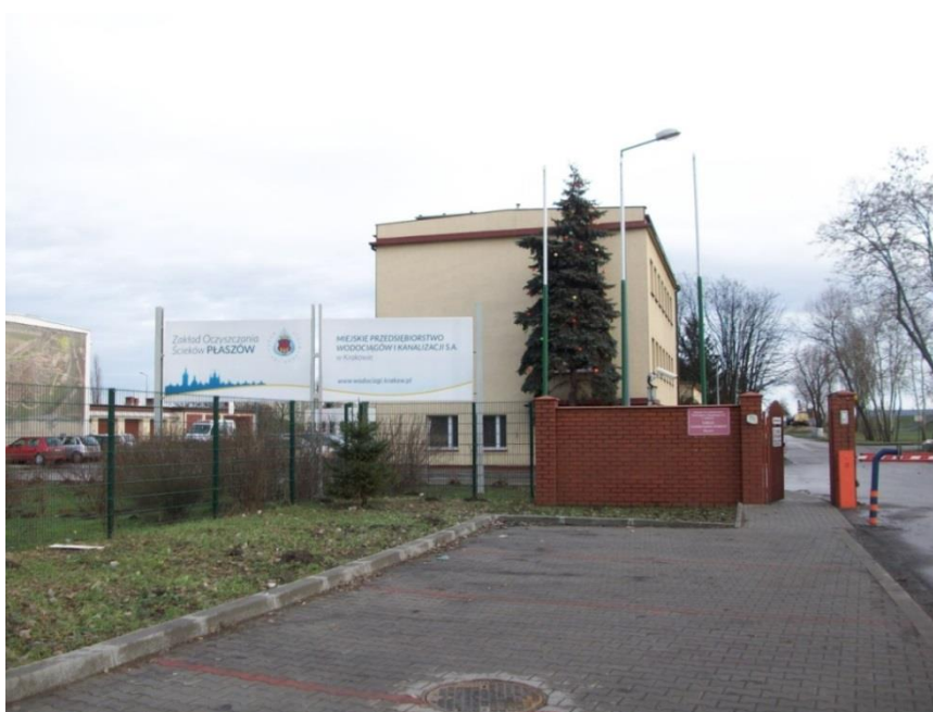
Rysunek 2. Wejście do zakładu oczyszczalni w Płaszowie.
