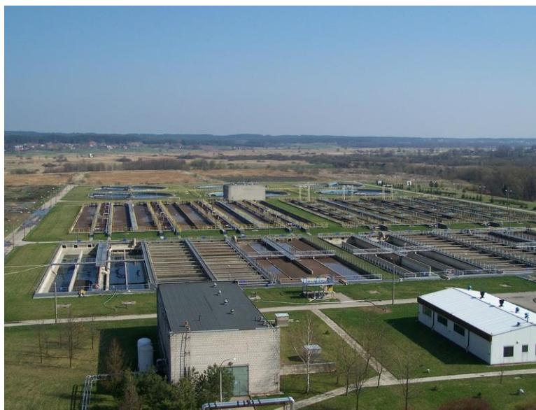
Rysunek 1. Ogólny widok na oczyszczalnię ścieków w Białymstoku
