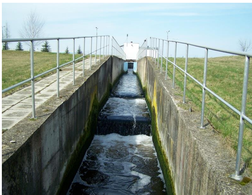
Rysunek 8. Kaskadowy kanał odprowadzający oczyszczone ściek do odbiornika
