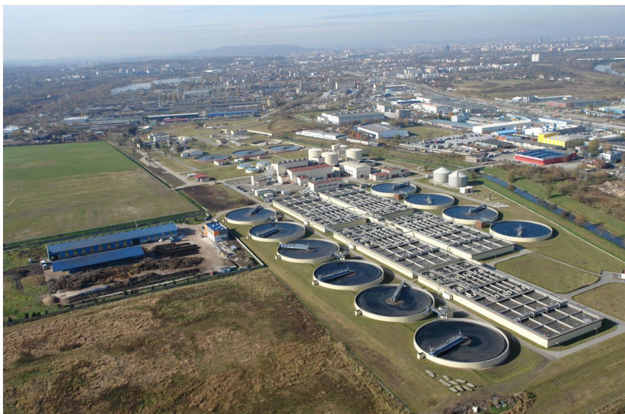
Rysunek 6. Oczyszczalnia dziś – widok z lotu ptaka
