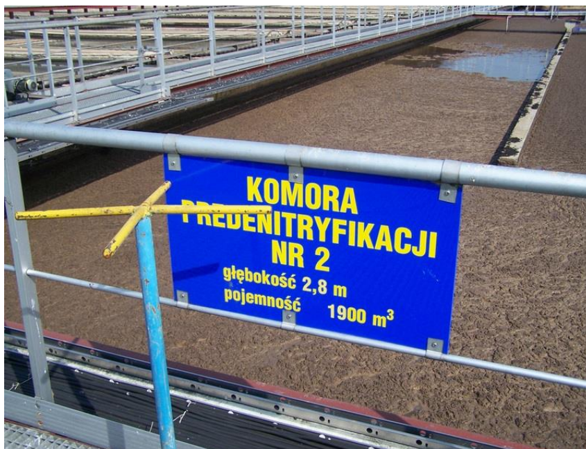
Rysunek 4. Komora predenitryfikacji
