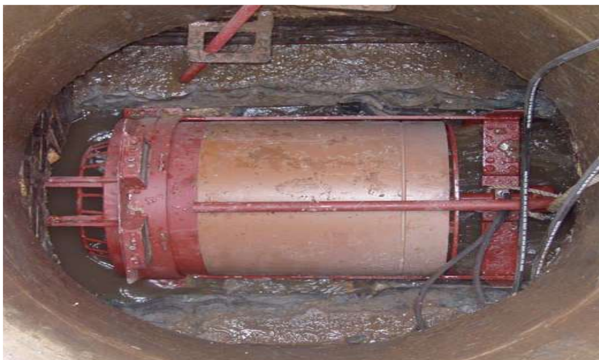
Rys. 21. Urządzenie montażowe opuszczone na dno studni startowej; w urządzeniu pierwszy modul KMR z założoną głowicą prowadzącą
