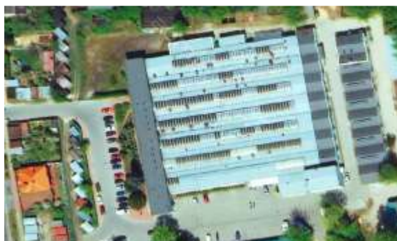
Rys. 8. Zdjęcie analizowanej zlewni
