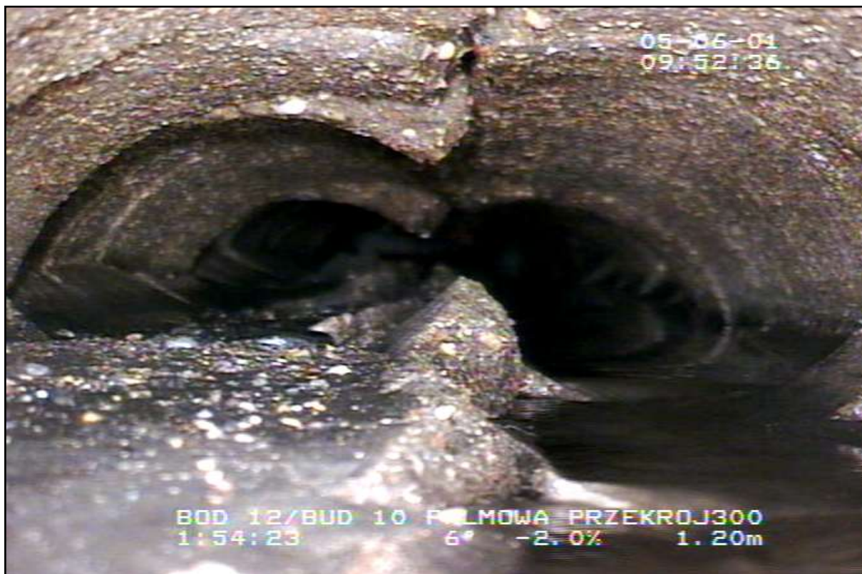
Rys. 14. Zapadanie się kanału tzw. „składanie się” [3]
