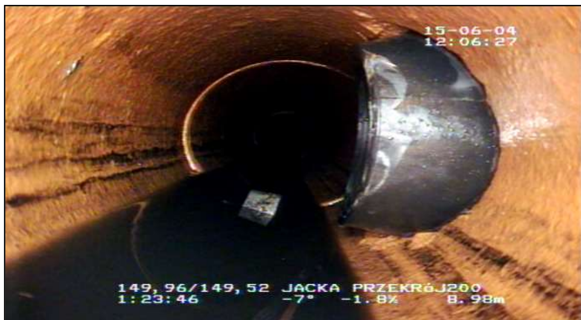
Rys. 4. Przyłącze kanalizacyjne wykonane do kanału kamionkowego w tzw. „oczko”
