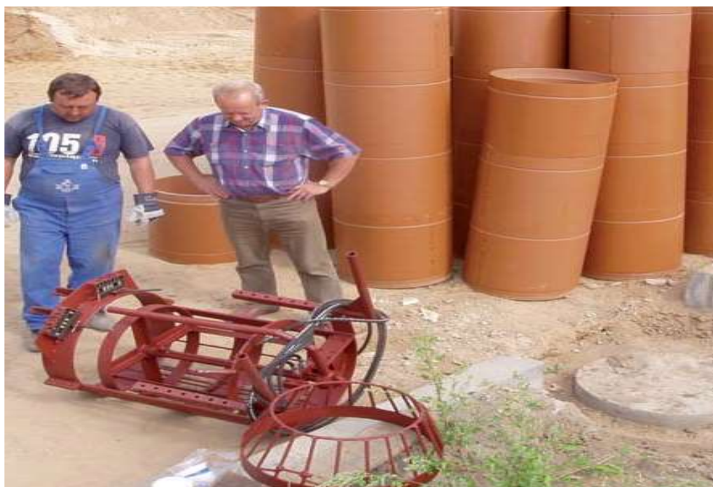
Rys. 20. Odbiór materiału KMR i sprzętu do ich montażu przez kierownika Wydziału Sieci Kanalizacyjnej Wodociągów Białostockich
