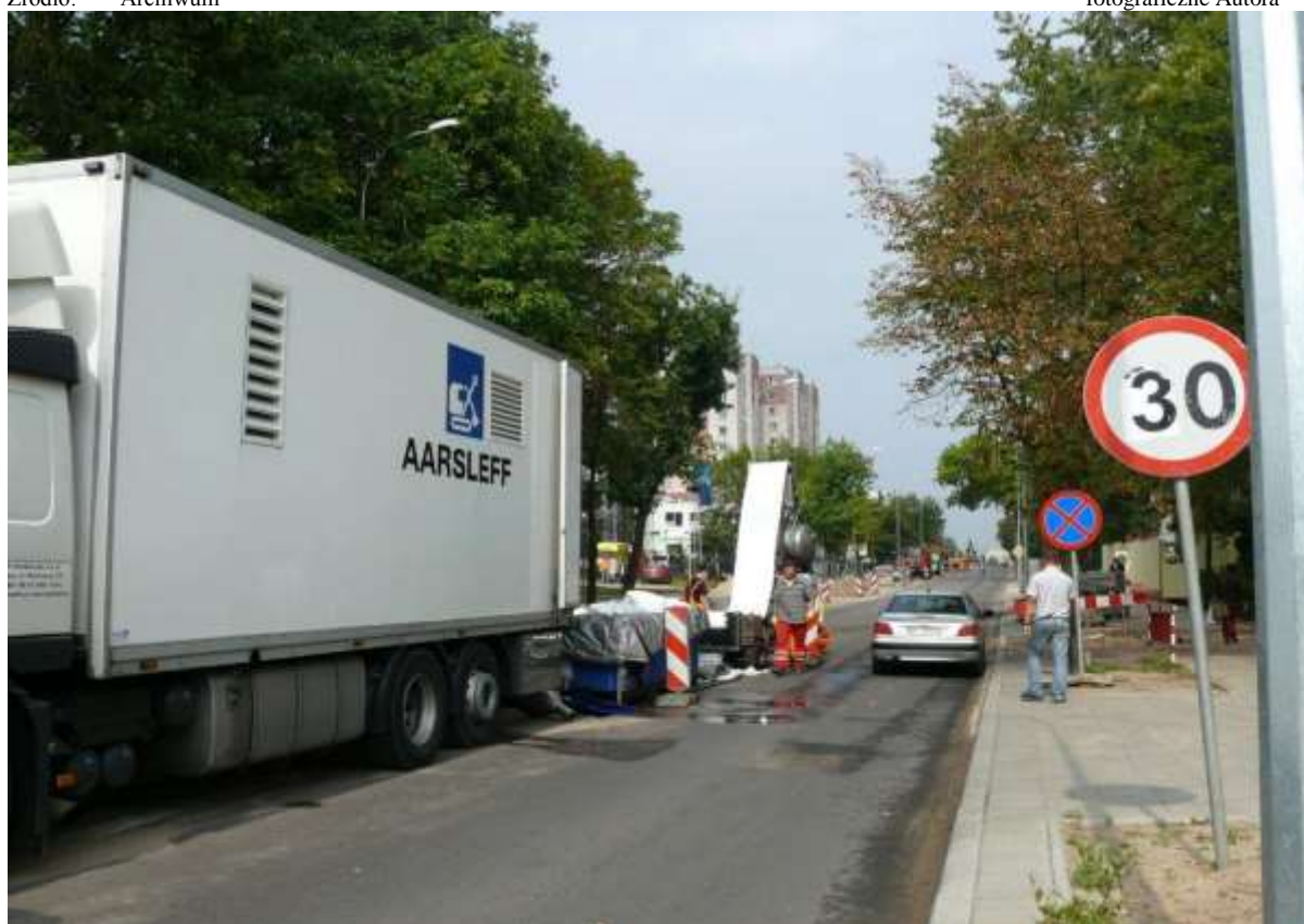
Rys.26. Renowacja kanału sanitarnego w ul. Mickiewicza w Białymstoku
