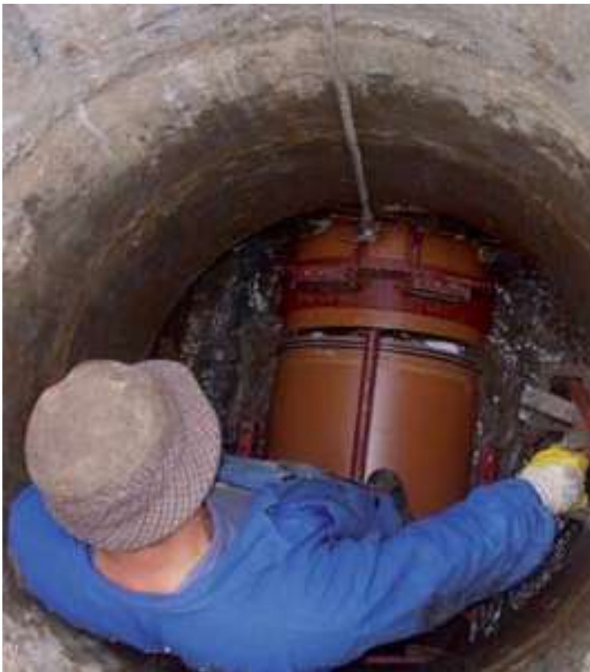
Rys. 23. Wprowadzanie KMR w głąb kanału
