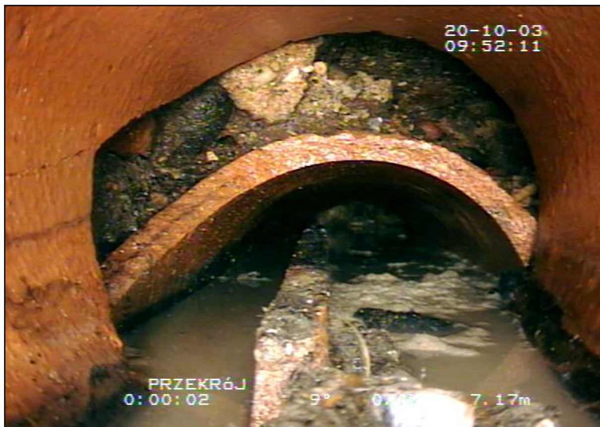
Rys. 17. Zwalenie się kanału kamionkowego[5]
