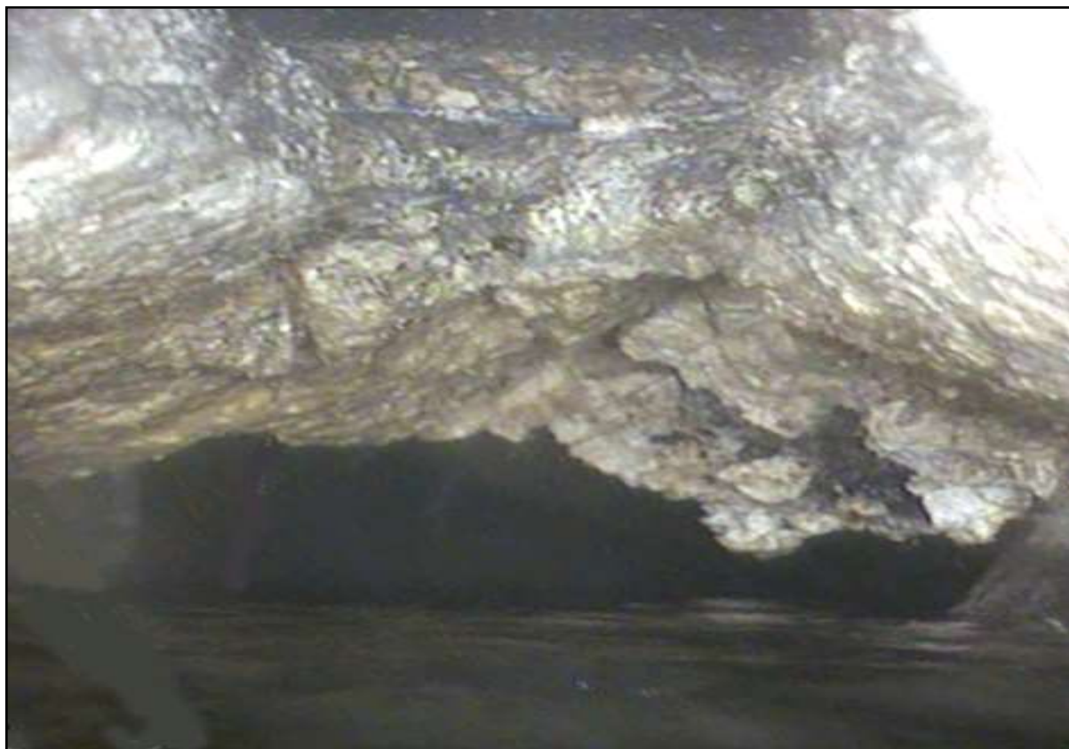
Rys. 16. Zarastanie kanału poprzez osiadające na szczycie tłuszcze [5]
