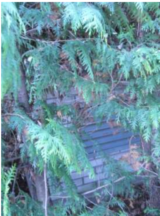
Rysunek 3. Czerpnia do GWC typu żwirowego obsadzona jodłami w Złotorii k. Białegostoku
