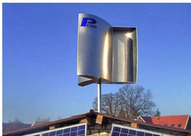
Rysunek 12. Turbina Savoniusa zainstalowana na obiekcie budowlanym
