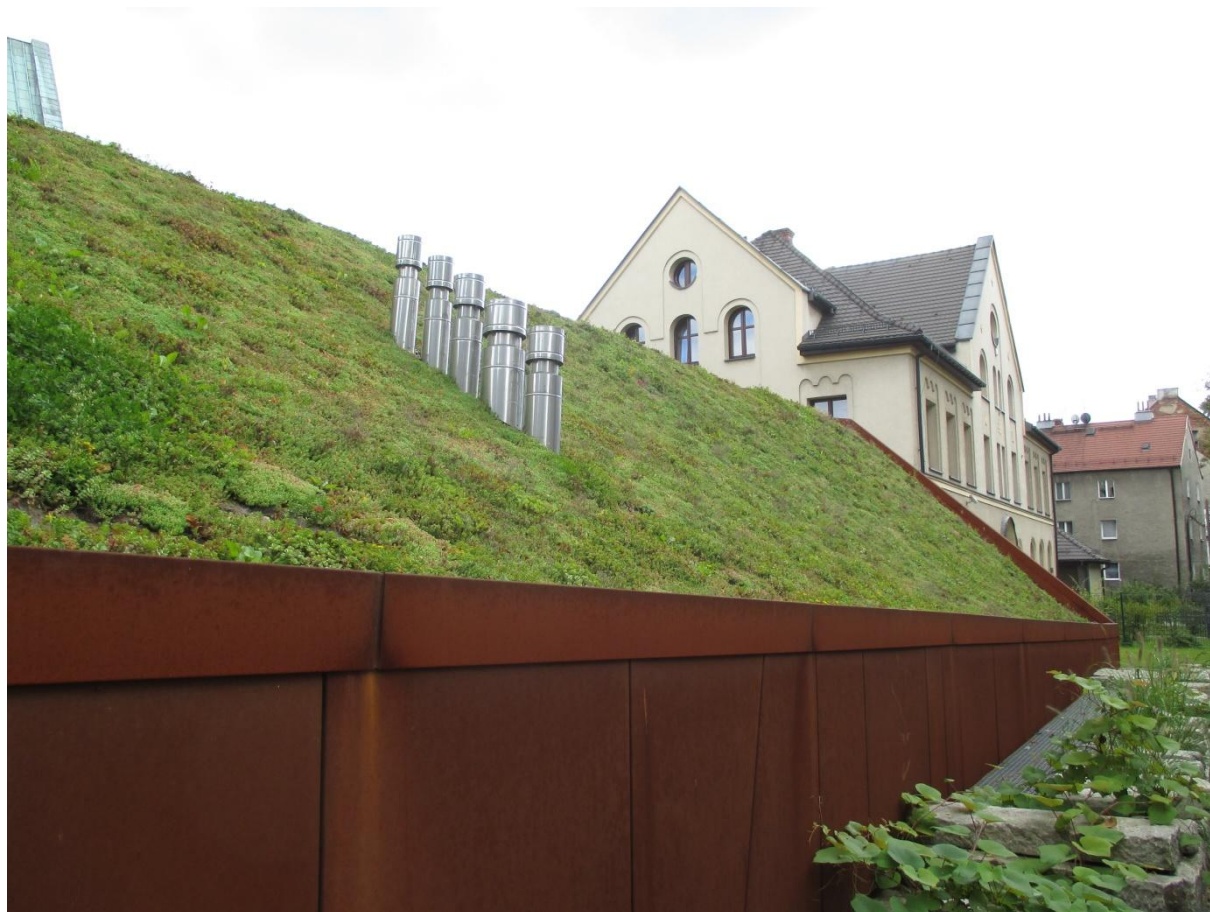
Rysunek 6. Dach zielony skośny z zastosowaną matą rozchodnikową
