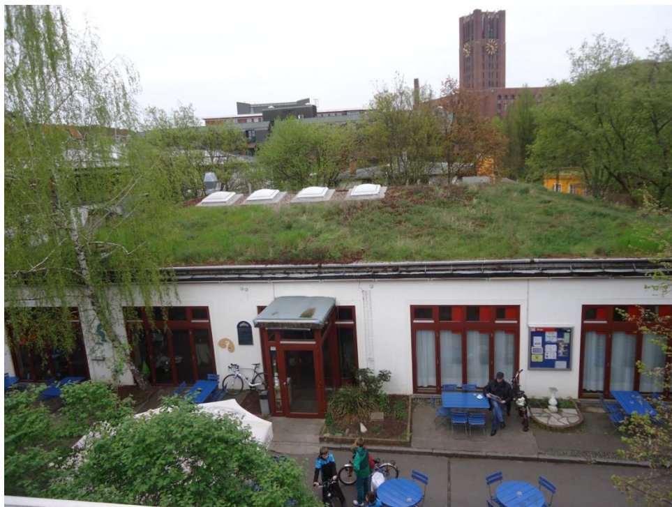
Rysunek 10. Zielony dach na restauracji w ufaFabrik
