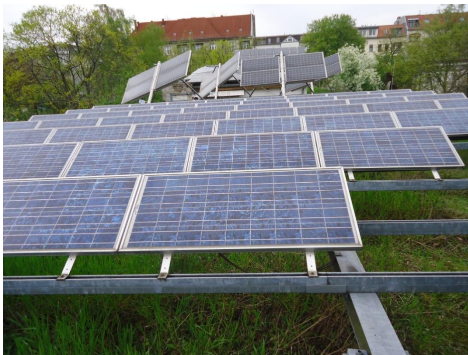
Rysunek 9. Panele słoneczne na dachu zielonym centrum kulturalnego ufaFabrik w Berlinie
