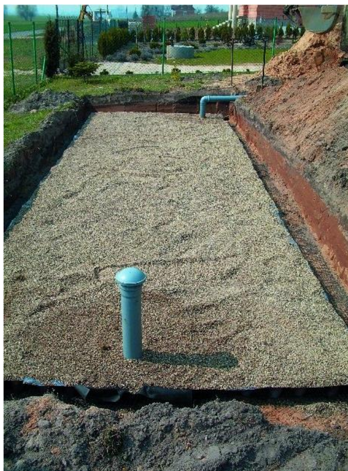
Rysunek 2. Oczyszczalnia z filtrem piaskowym
