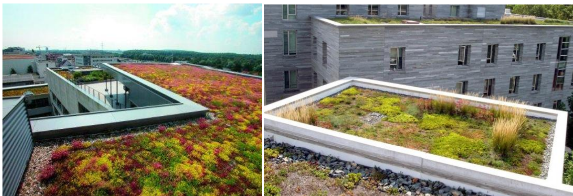
Rysunek 10. Dach ekstensywny z rozchodników
