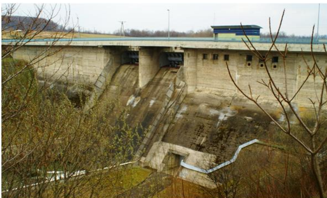
Rysunek 1. Strona odpowietrzna zapory betonowej w Besku
