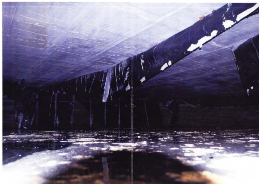
Rysunek 6. Widok z wnętrza pustki pod tunelem Wisłostrady (materiały AGP)
