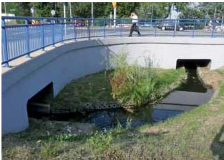
Rysunek 11. Przykład żelbetowych przepustów ramowych
