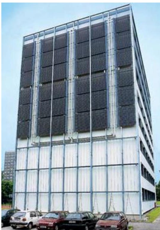
Rysunek 16. Kolektory słoneczne próżniowe rurowe w obrębie elewacji w Domu Studenckim w Lipsku w Niemczech
