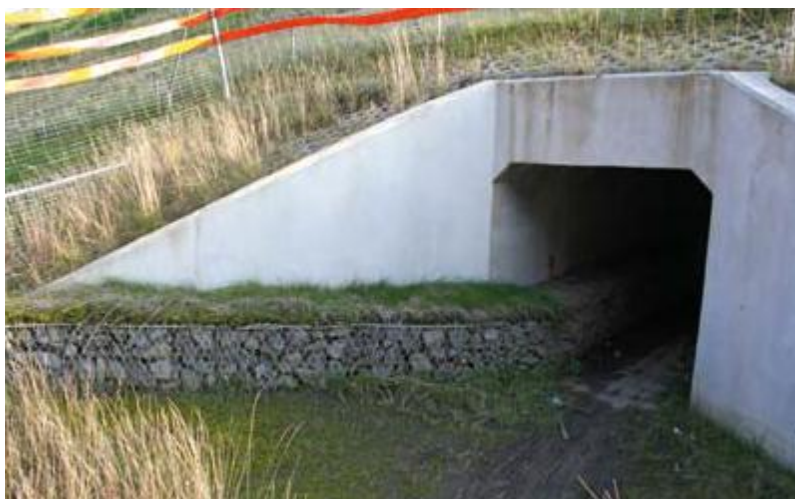
Rysunek 6. Półka gabionowa pokryta gruntem i darniną
