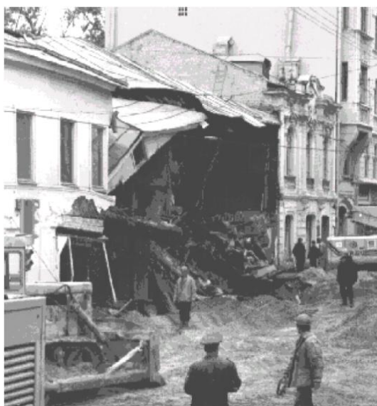
Rysunek 4. Budynek zniszczony na skutek wyniesienia podłoża spod jego fundamentów do drążonego poniżej tunelu, Moskwa 1998
