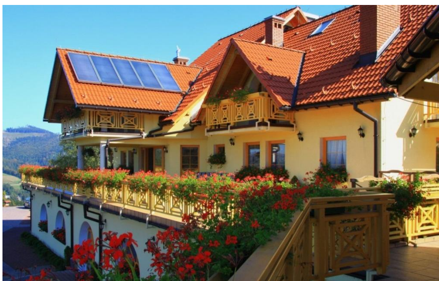
Rysunek 4. Pensjonat „Karolowy Dwór” w Wiśle – na dachu bateria płaskich kolektorów słonecznych
