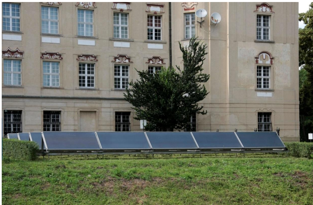
Rysunek 9. Bateria płaskich kolektorów słonecznych - Pałac Rydzyna
