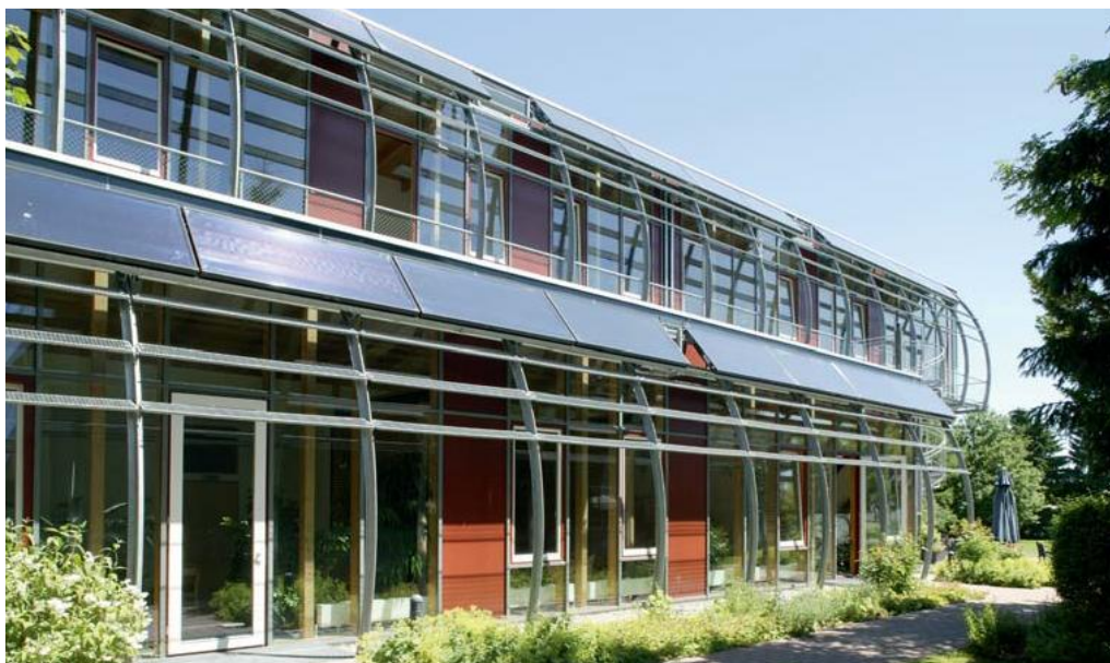
Rysunek 14. Kolektory słoneczne Vitosol 200-F firmy Viessmann w szkole sportowej w Albstadt
