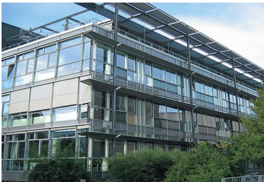
Rysunek 15. Cieczowe kolektory słoneczne (zwieńczenie południowej elewacji) zastosowane na biurowcu WAT GmbH w Karlsruhe
