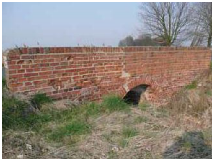
Rysunek 8. Tradycyjny ceglany przepust sklepiony
