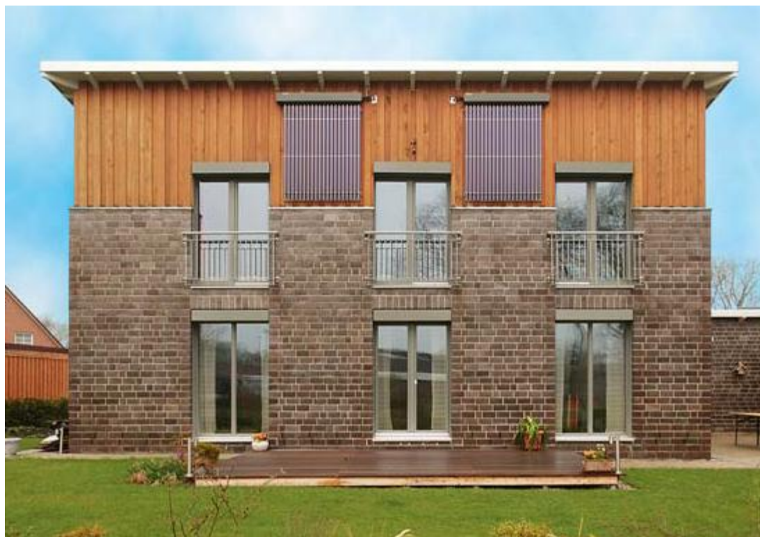
Rysunek 7. Kolektory słoneczne próżniowe rurowe Vitosol 300-T na ścianie domu pasywnego w Kaltenkirchen
