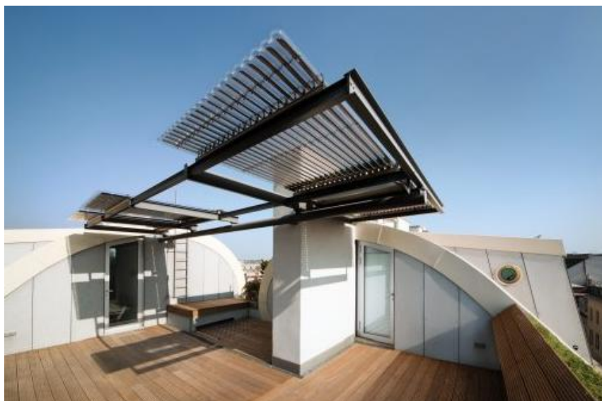
Rysunek 18 Kolektory słoneczne próżniowe rurowe Vitosol 200-T - Penthouse, Wiedeń, Austria
