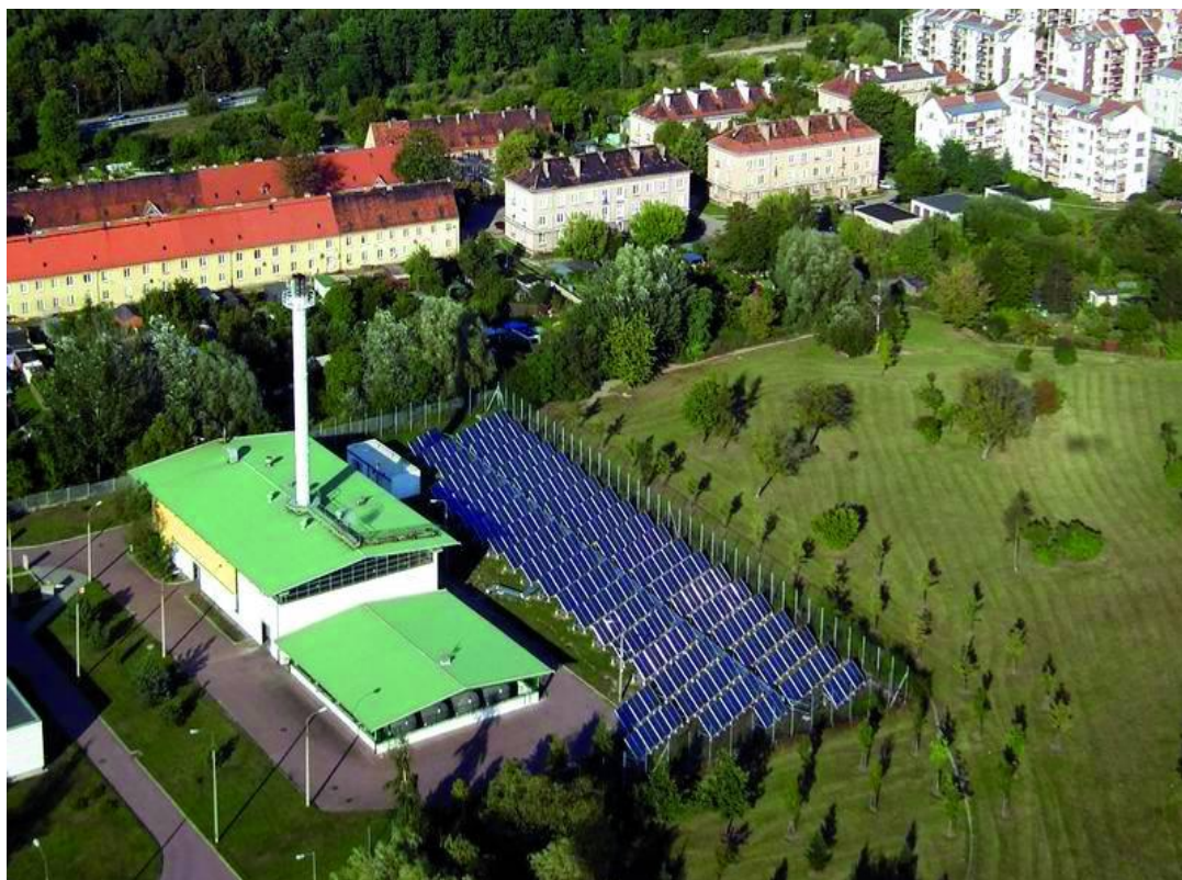
Rysunek 8. Instalacja solarna płaskich kolektorów słonecznych Viessmann Vitosol 200-F Wielospecjalistycznego Szpitala Miejskiego im. Józefa Strusia w Poznaniu
