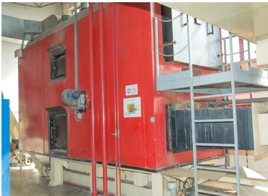
Rysunek 12. Kocioł o mocy cieplnej 1,5 MW w ZGK w Łukcie
