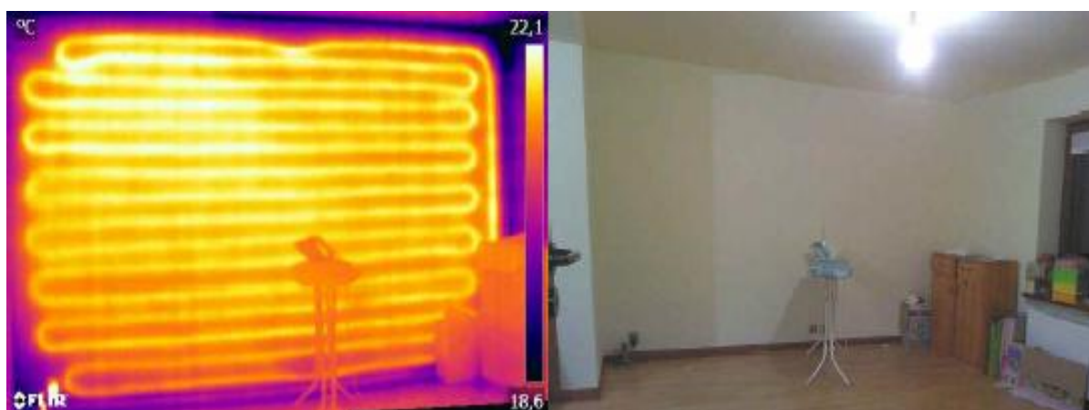
Fot. 4.11. Lokalizacja położenia instalacji ogrzewania ściennego (z lewej: termogram, z prawej: stan zastany)
