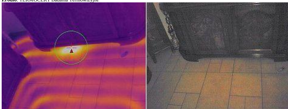
Fot. 4.3. Wyciek wody z instalacji ogrzewania podłogowego, zlokalizowany pod posadzką (z lewej: termogram, z prawej: stan zastany)
