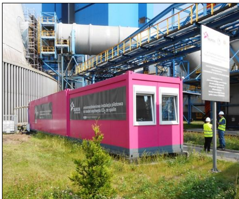
Rysunek 4. Widok instalacji pilotowej DR-VPSSA podłączonej do kanału spalin
