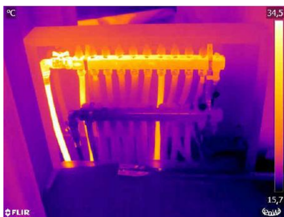
Fot. 4.14. Analiza pracy rozdzielacza ogrzewania (z lewej: termogram, z prawej: stan zastany)
