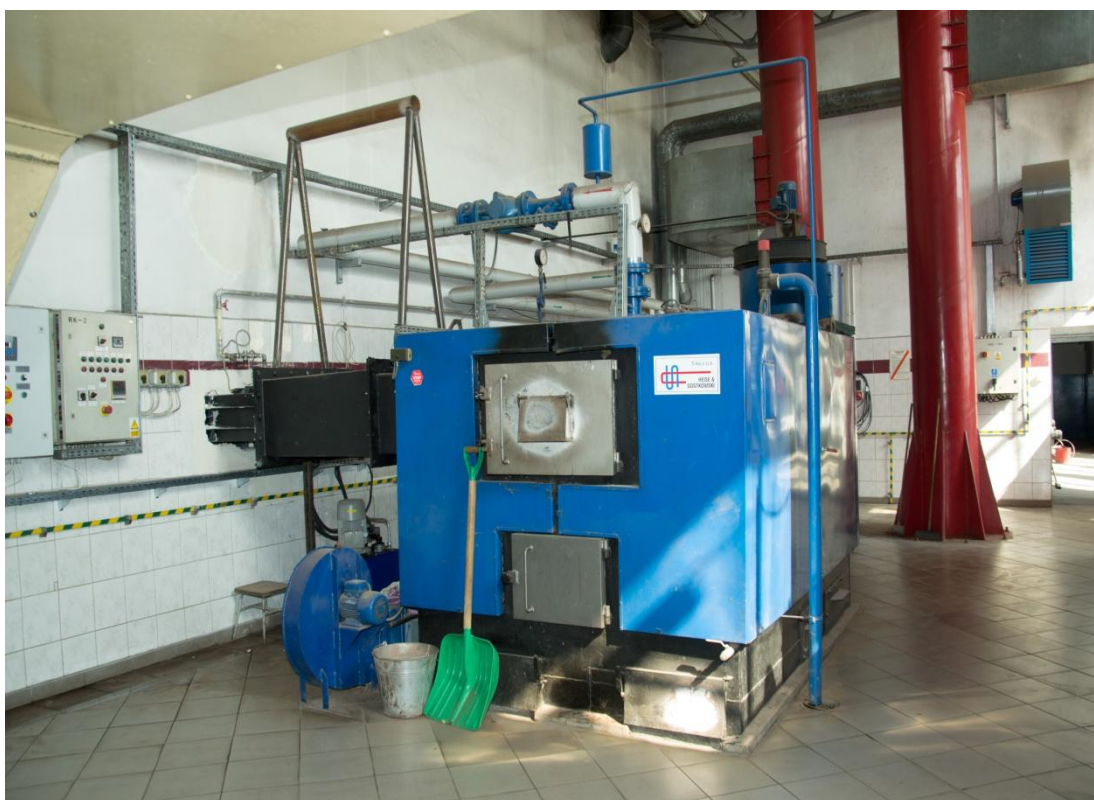
Rysunek 15. Kocioł o mocy cieplnej 0,5 MW w ZGK w Łukcie
