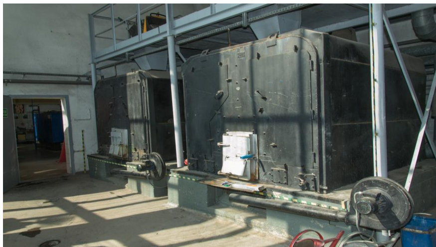
Rysunek 18. Stare, nieużywane kotły znajdujące się w budynku kotłowni
