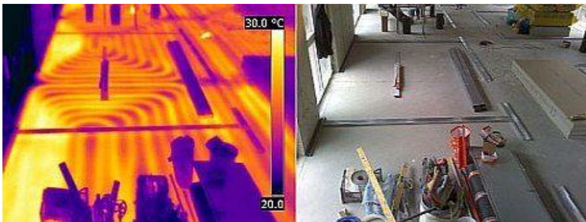
Fot. 4.10. Sprawdzenie szczelności instalacji ogrzewania podłogowego po zamocowaniu metalowych kątowników (z lewej: termogram, z prawej: stan zastany)
