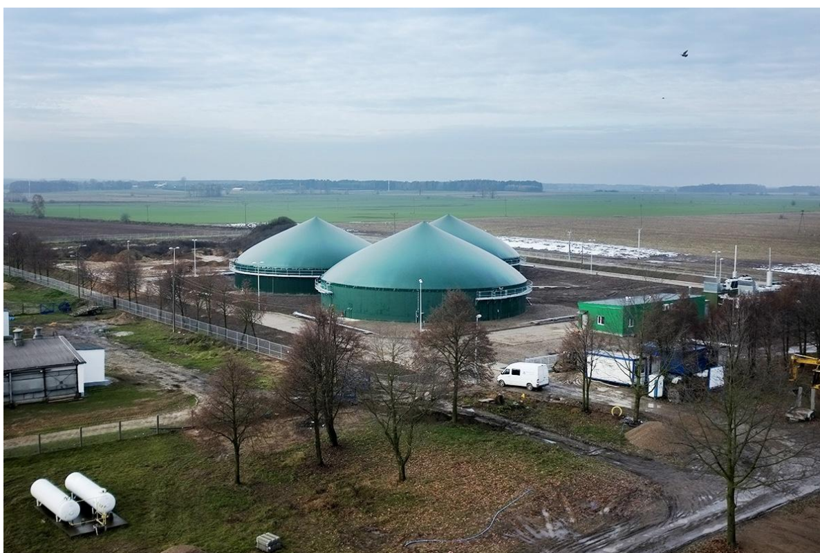
Rysunek 1. Biogazownia w Rybolach – zbiorniki fermentacyjne
