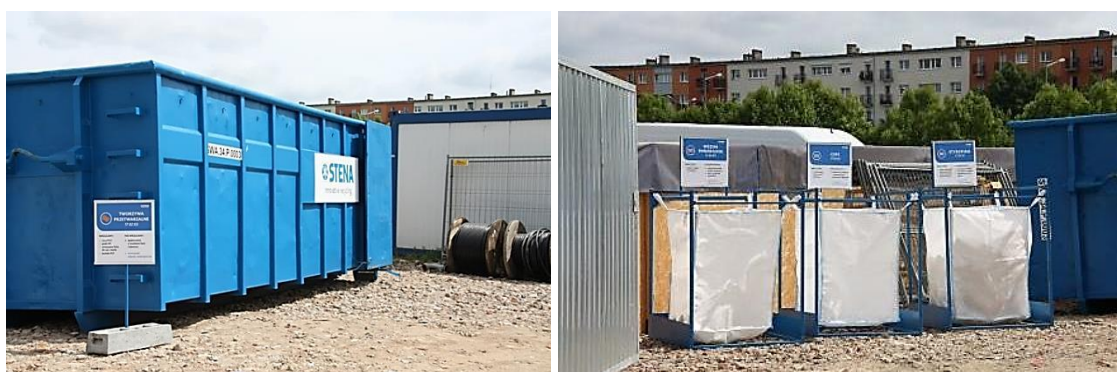
Rysunek 3. Rozwiązania w zakresie gospodarowania odpadami na budowie Business Garden Poznań
