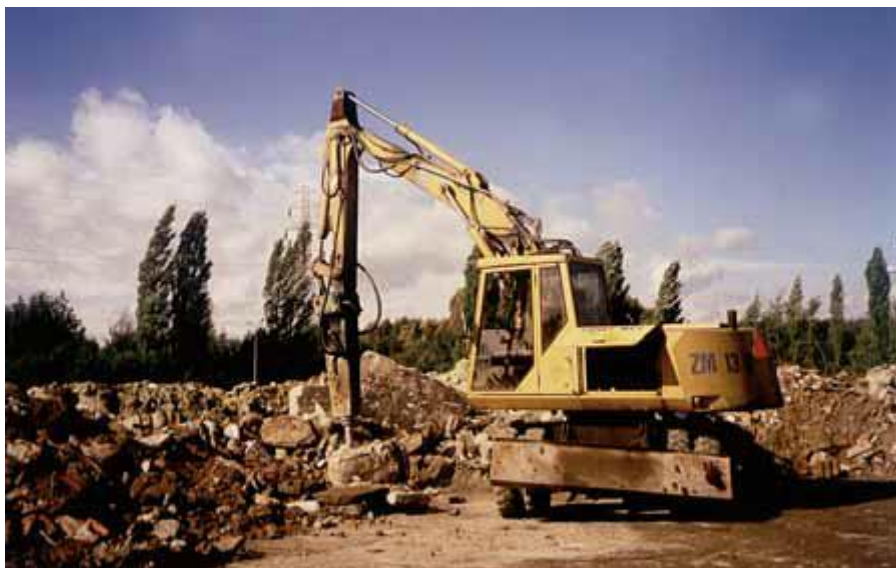
Rysunek 1. Rozdrabnianie i kruszenie gruzu przy obiekcie
